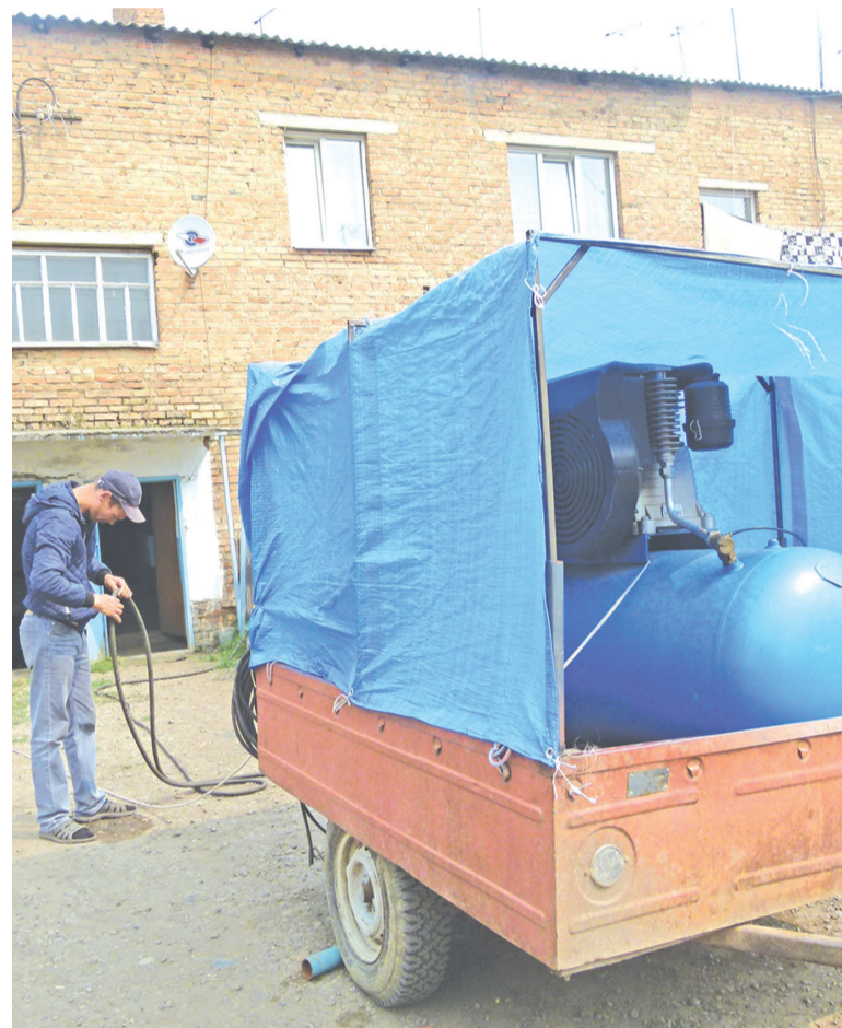
Промывка системы отопления
